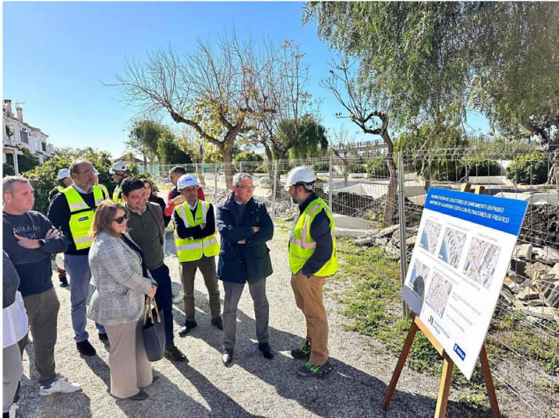
Obras en Algarrobo / Diputación de Málaga
