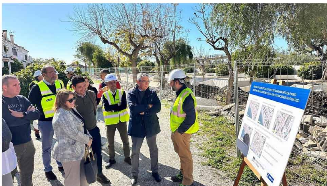
La Diputación financia la mejora de colectores de saneamiento en Algarrobo para aprovechar las aguas regeneradas.
