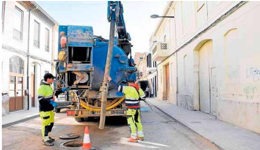
Operarios de la contrata en una calle de Alfafar. AYTO. ALFAFAR
